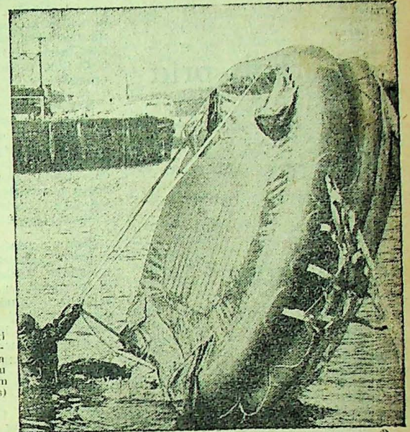
Ini adalah suatu demonstrasi jang memamerkan bagaimana menurunkan dan menaikkan jang dinamakan „Elliot Life raft" dari darat keatas kapal, jang berlangsung disebuah kapal di East India Harbour. Utuk menurunkan dan menaikkannya kekapal rata2 memerlukan waktu selama hanya 30 sampai 45 detik. Elliot Life rafts adalah sedjenis „sekotji pelambung" jang dapat digunakan sebagai alat penolong bagi ketjelakaan ditengah laut, jang kini digunakan setjara luas oleh dunia perkapalan Inggris.
